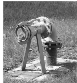
Foto KMS – Beispiel Perrot-Kupplung
