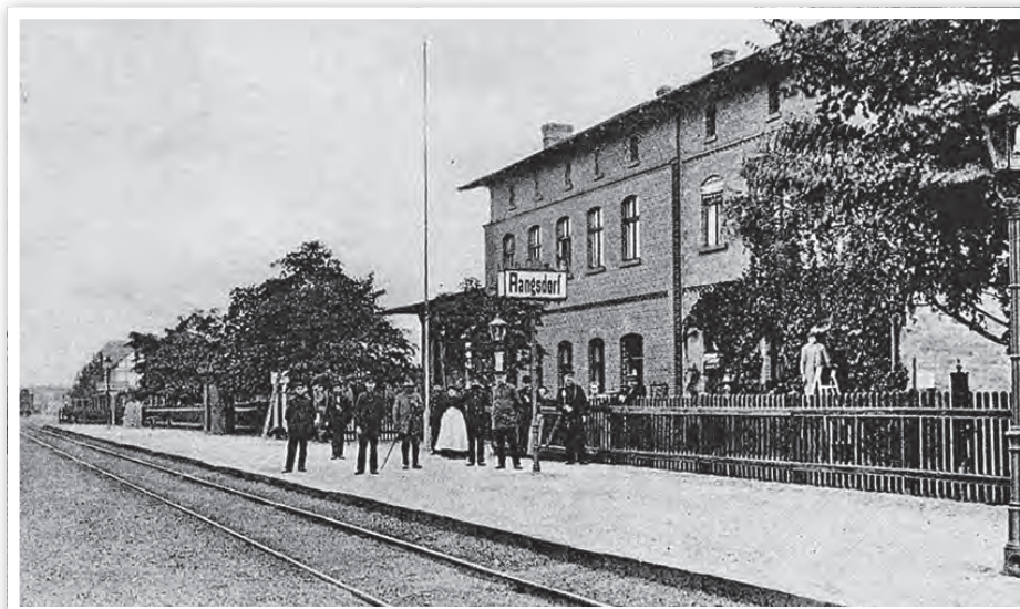
Der Bahnhof Rangsdorf mit dem Stationsgebäude der BDE um 1907.
