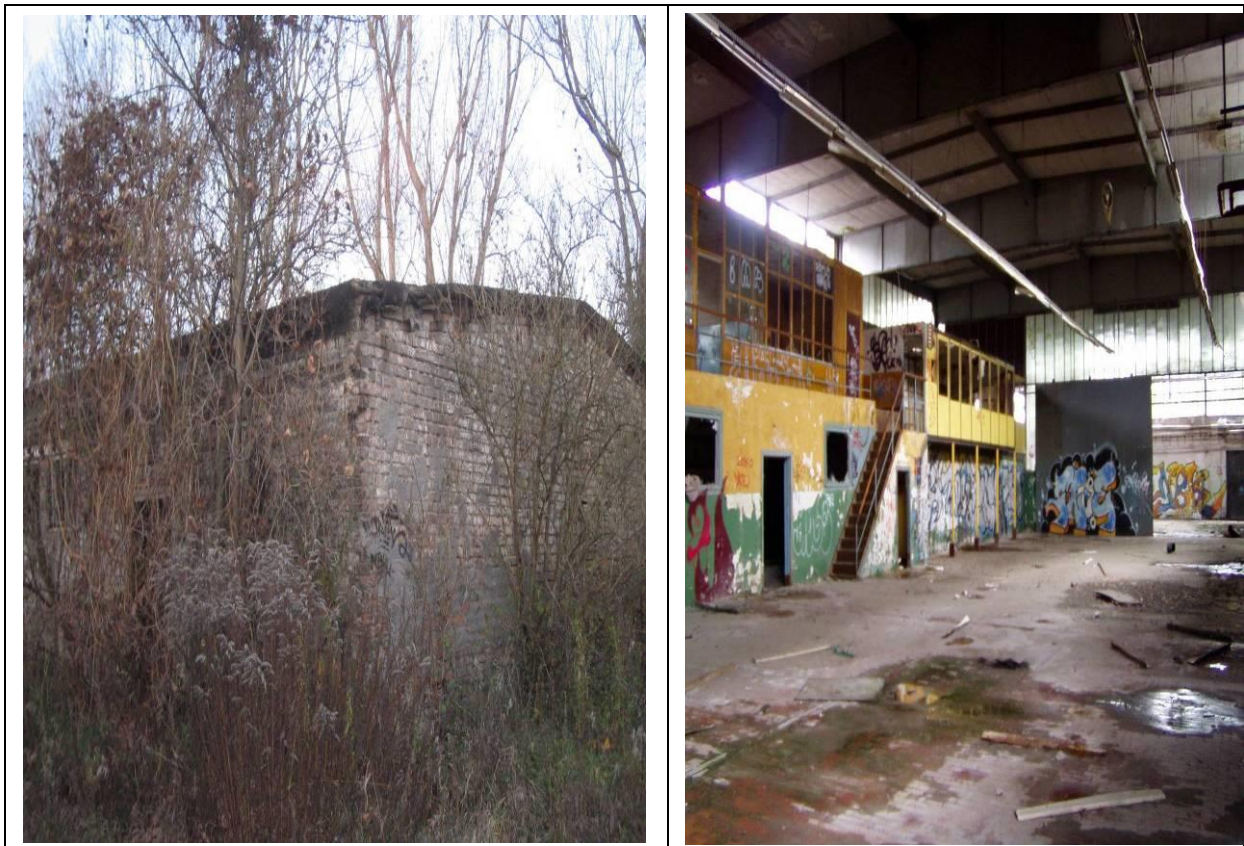
Abb. 9 und 10: Die alte Bausubstanz sowie das Innere der Werkhallen weist generell als Sommerquartier geeignete Strukturen auf. Es konnten keine Anzeichen auf eine aktuelle Nutzung festgestellt werden.
