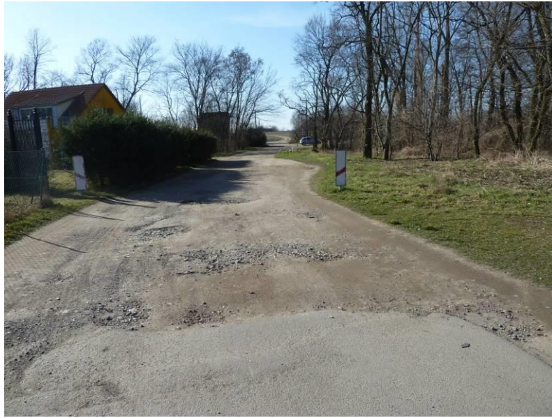
Abb. 6: Die Pramsdorfer Straße von der Bergstraße Richtung Bahnübergang gesehen
